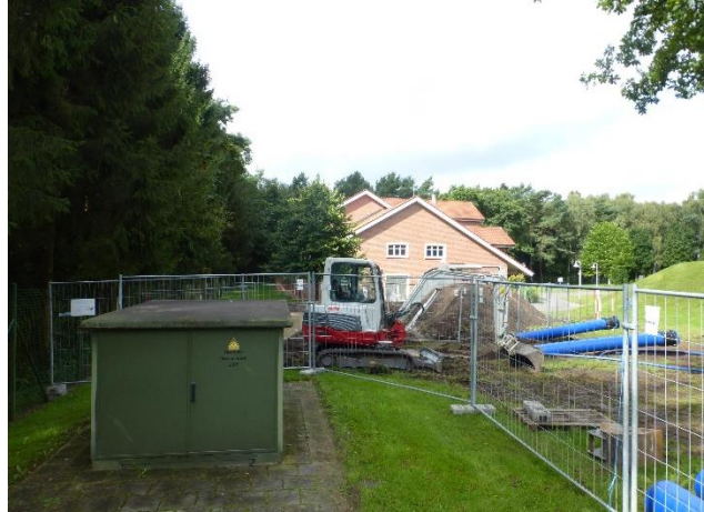
Zielgrube nach dem Einzug der TW-Leitungen
